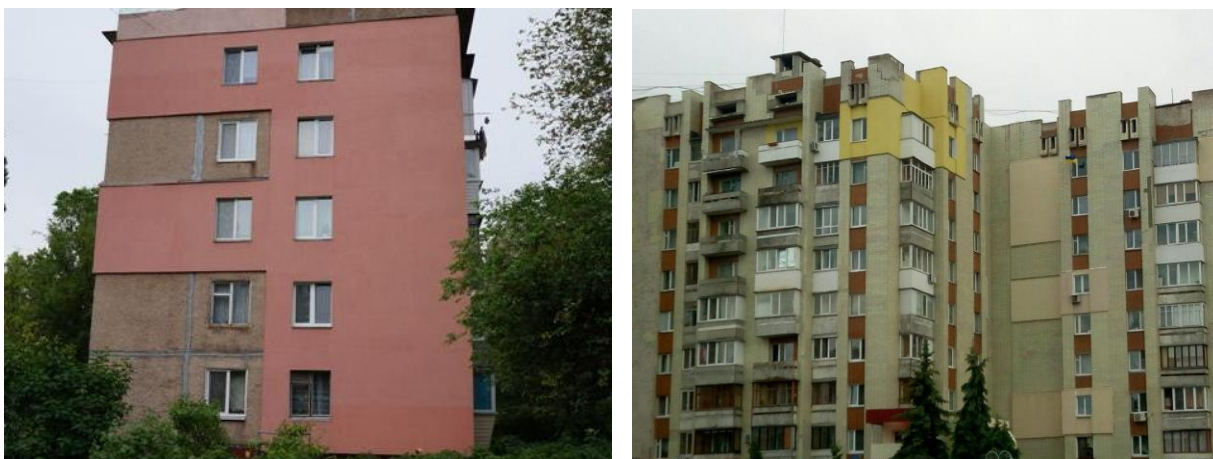
Рис. 7. Утеплення зовнішніх стін окремих квартир будівель
