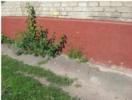
Рис. 4. Біозабруднення та руйнування вимощення
