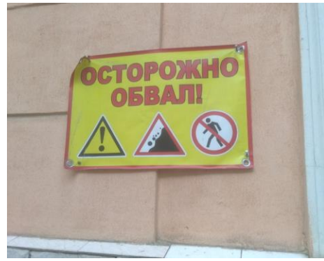
Рис. 3. Попередження на аварійному фасаді будинку
