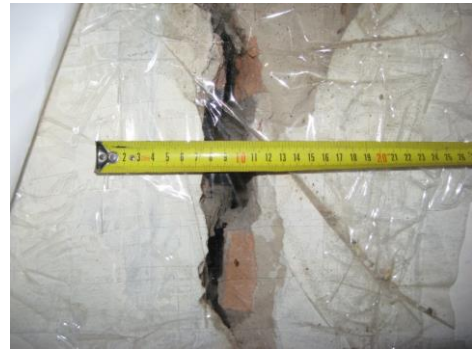
Рис. 5. Наскрізні тріщини осадового характеру у повздовжніх несучих стінах будинку
