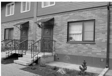
а) вхід до квартир
