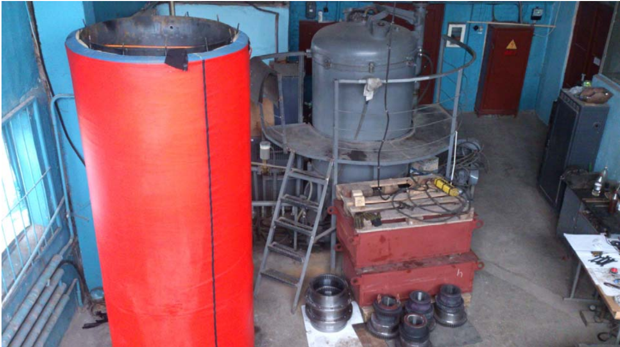
Рис. 3. Встановлений теплоаккумулятор системи опалення в цеху азотування
