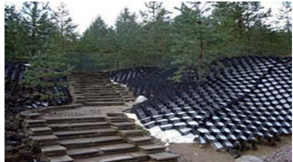
Рис. 2. Використання георешітки разом з геотекстилем
