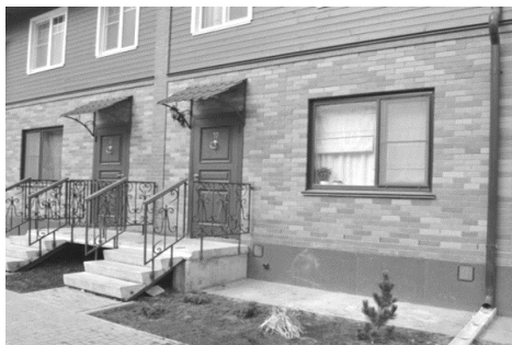
а) вхід до квартир
