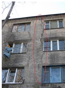
Рис. 5. Наскрізні тріщини осадового характеру у повздовжніх несучих стінах будинку
