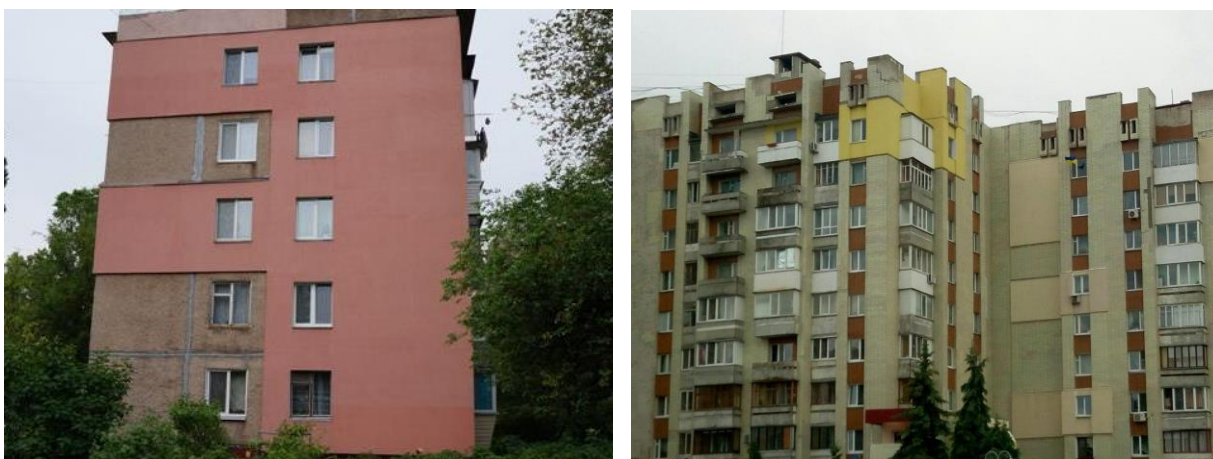
Рис. 7. Утеплення зовнішніх стін окремих квартир будівель
