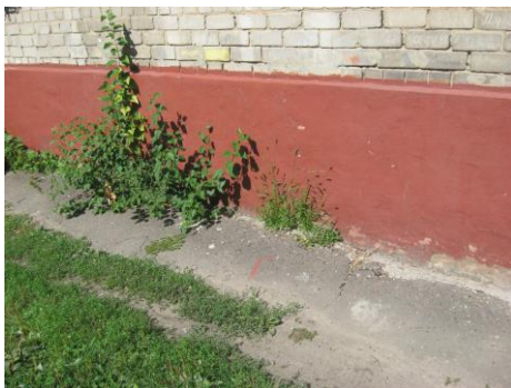
Рис. 4. Біозабруднення та руйнування вимощення
