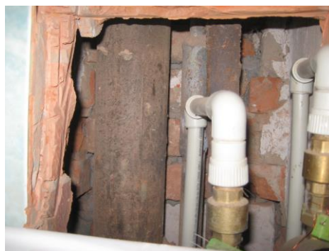
Рис. 6. Часткова заміна мереж водопостачання і водовідведення у будинках
