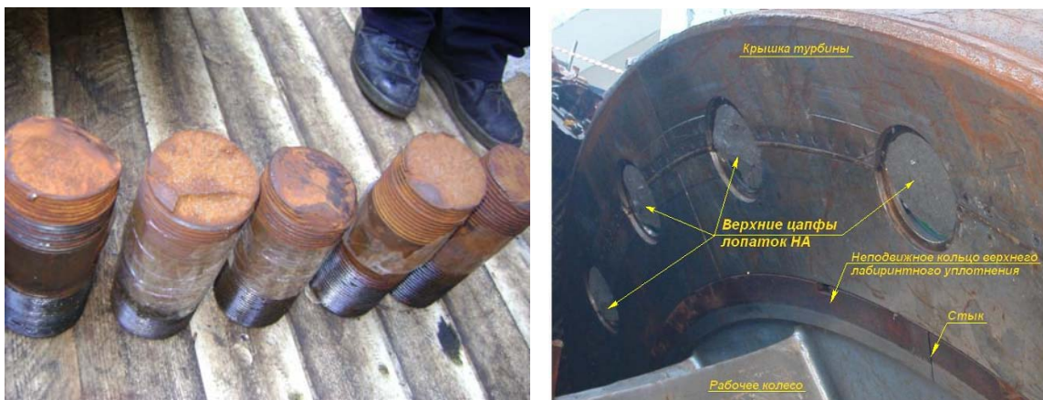
Рис. 9. Фотографії зламаних шпильок кришки турбіни [26] (зліва) та зламаних верхніх цапф лопаток направляючого апарату [27] (справа) другого гідроагрегату СШГЕС
