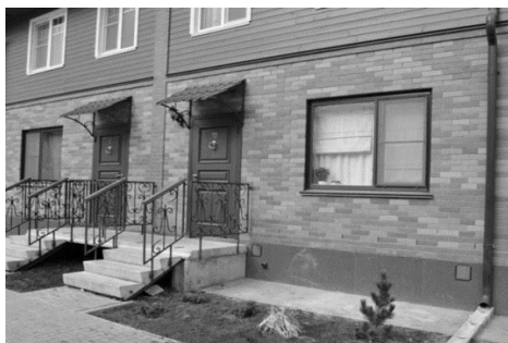
а) вхід до квартир
