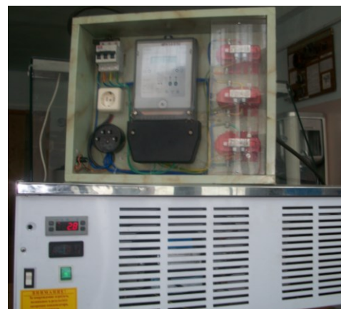
Рис. 9. Лабораторна холодильна установка, оснащена комплектним приладом для вимірювання електричних і енергетичних параметрів
